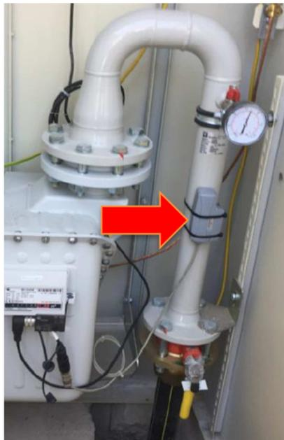
Figure 4 Fixation sur tuyau
