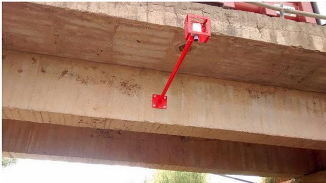
Boîtier fixé sur un support avec tige de déport
